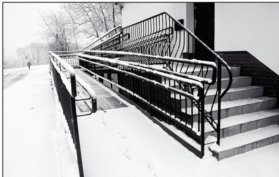
Do mieszkania prowadzi podjazd dla wózków
